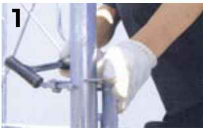
1 固定金具を、ハンマーで固定して設置
